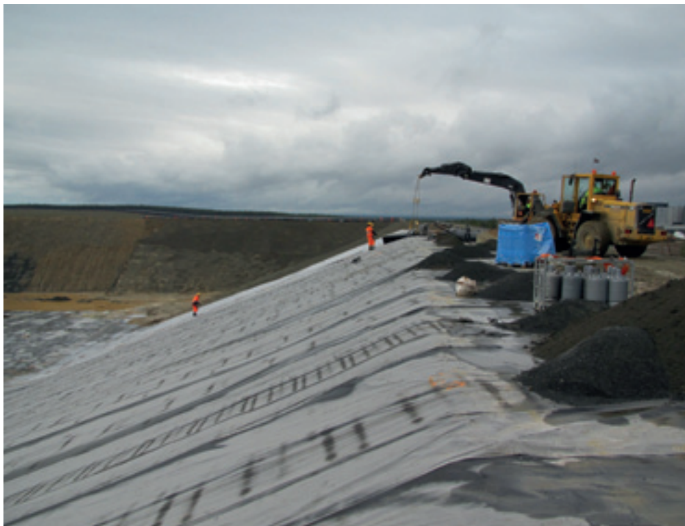
Kuva 30. Kumibitumikermi kaivospadon märkäpuolen päällysrakenteena, Kevitsan kaivos. Kumibitumikermi (+ bentoniittimaton) alla on yläosasta tiivistetty moreenikerros rajautuen louheeseen (vasenlata, ks. myös kuva 29). (Kuva Timo Regina)
